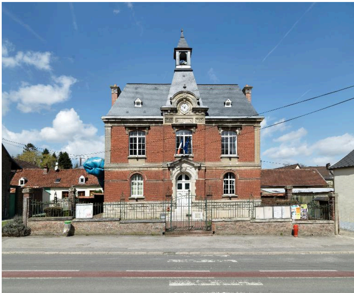
Vue d'ensemble de la façade sur rue.
