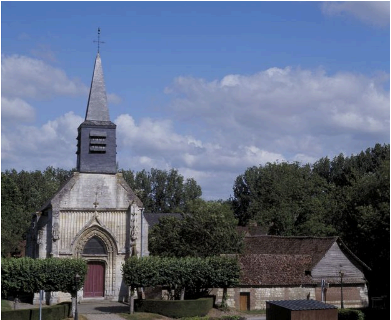
Vue de situation de l'église et des dépendances agricoles du moulin.
