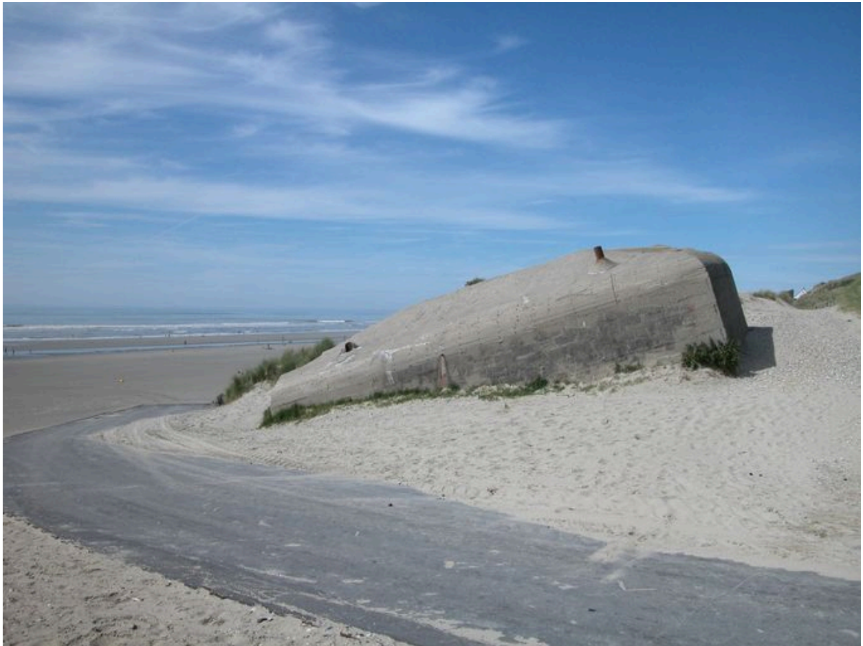
Un blockhaus au sud de la digue.
