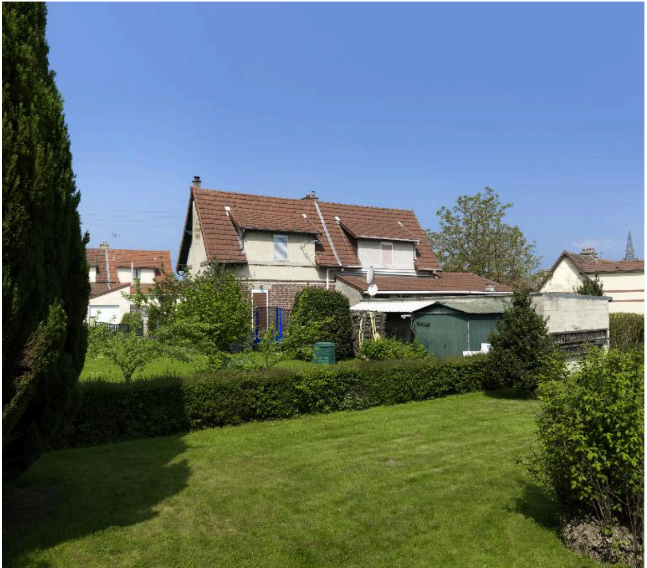
Maison de type C, vue générale de la façade arrière sur jardin (rue Pasteur).
