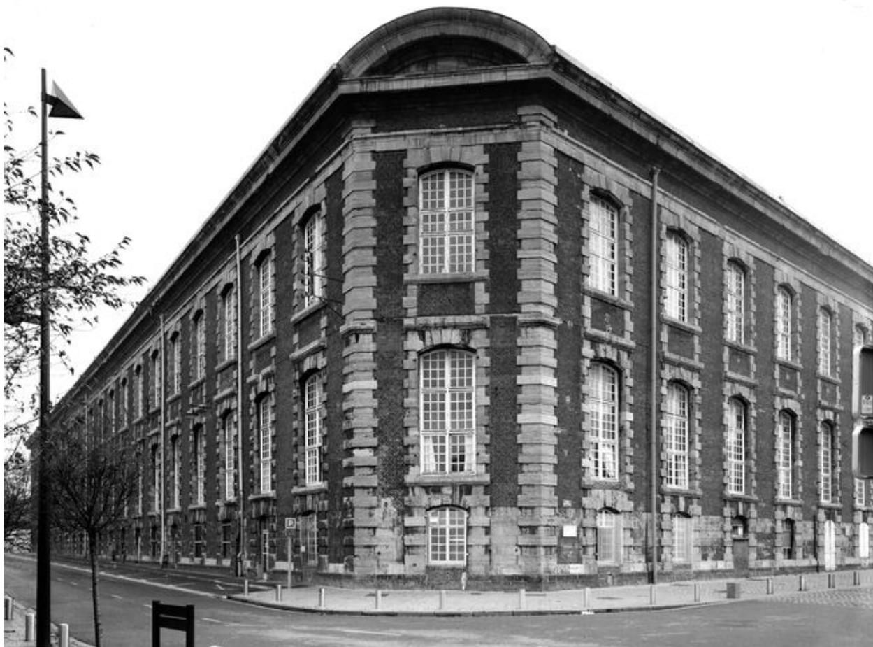
Elévation latérale gauche donnant sur la rue de Jemmapes, vue générale prise de trois-quarts droit montrant l'extrémité gauche de la façade principale.
