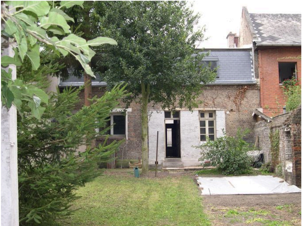
Ancien logement de l'instituteur, vue de la façade sur le jardin.
