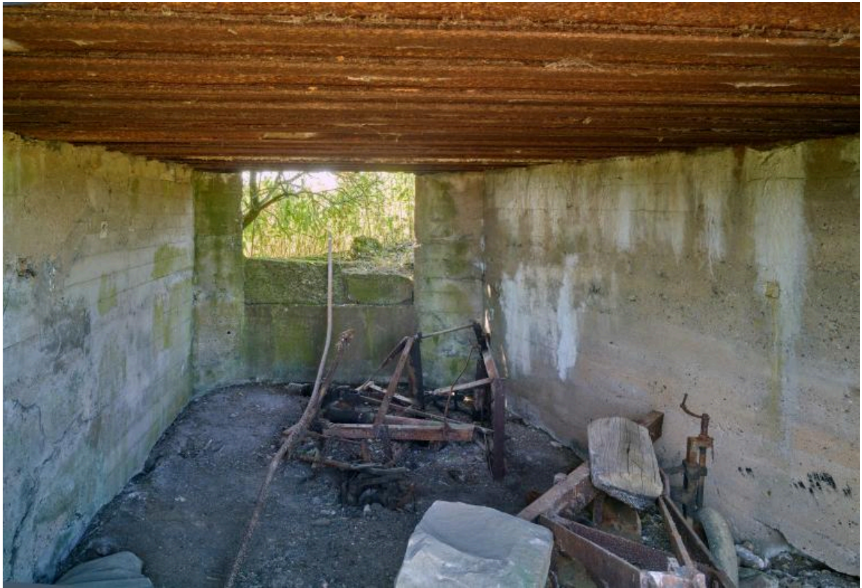
Vue longitudinale de la chambre de tir.
