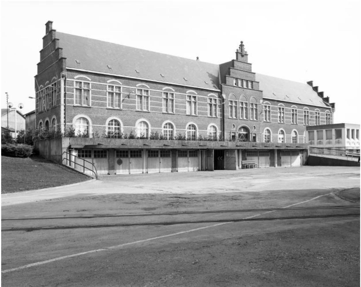
Grands bureaux de l'usine Vallourec construits par Lafitte en 1928.
