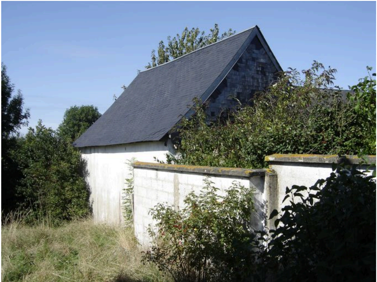
Vue postérieure des dépendances.
