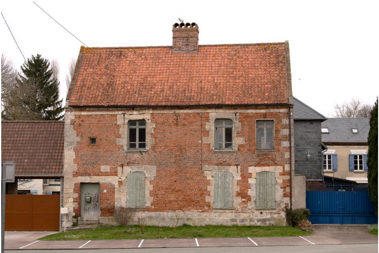
Maison dite du chapitre (ancien presbytère), vue depuis le sud.
