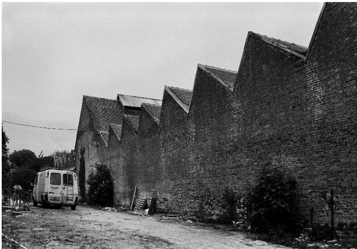
Atelier de fabrication, flanc est, en 1990.
