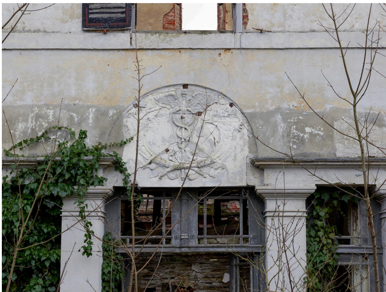
Détail de la sculpture en bas-relief ornant le linteau de la porte d'entrée du logement patronal.
