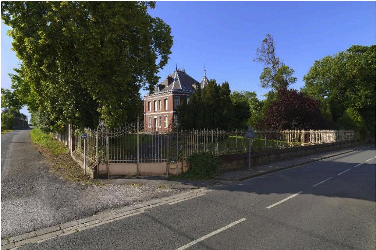
Vue de trois-quarts depuis la rue Jean-Catelas.
