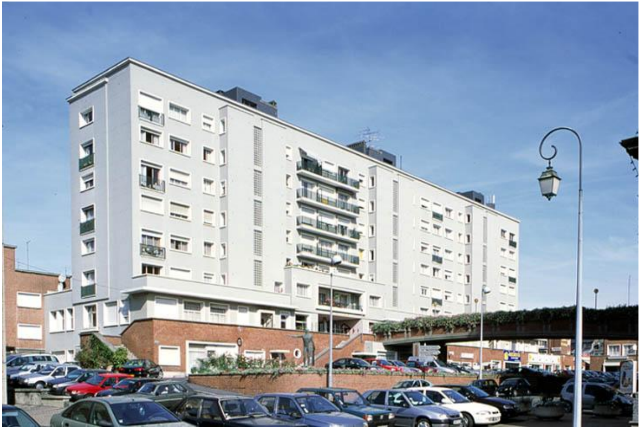
Vue générale de l'élévation sur la rue du Lieutenant-colonel-Martin.
