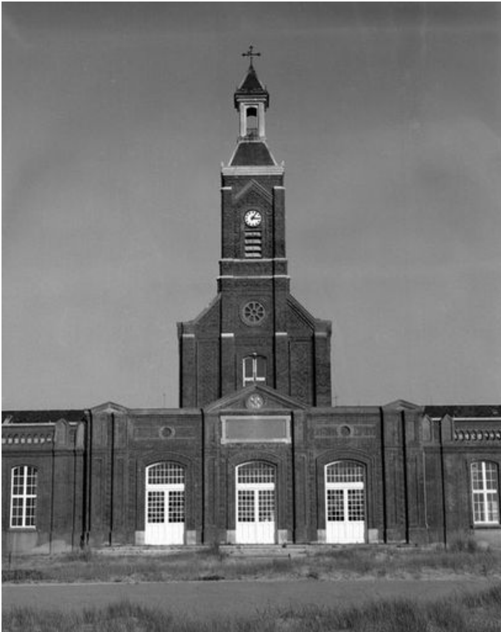
Corps de logis principal, élévation antérieure, détail de l'entrée de l'hôpital sur l'esplanade avec la saillie de la façade de la chapelle au-dessus, vue de face.
