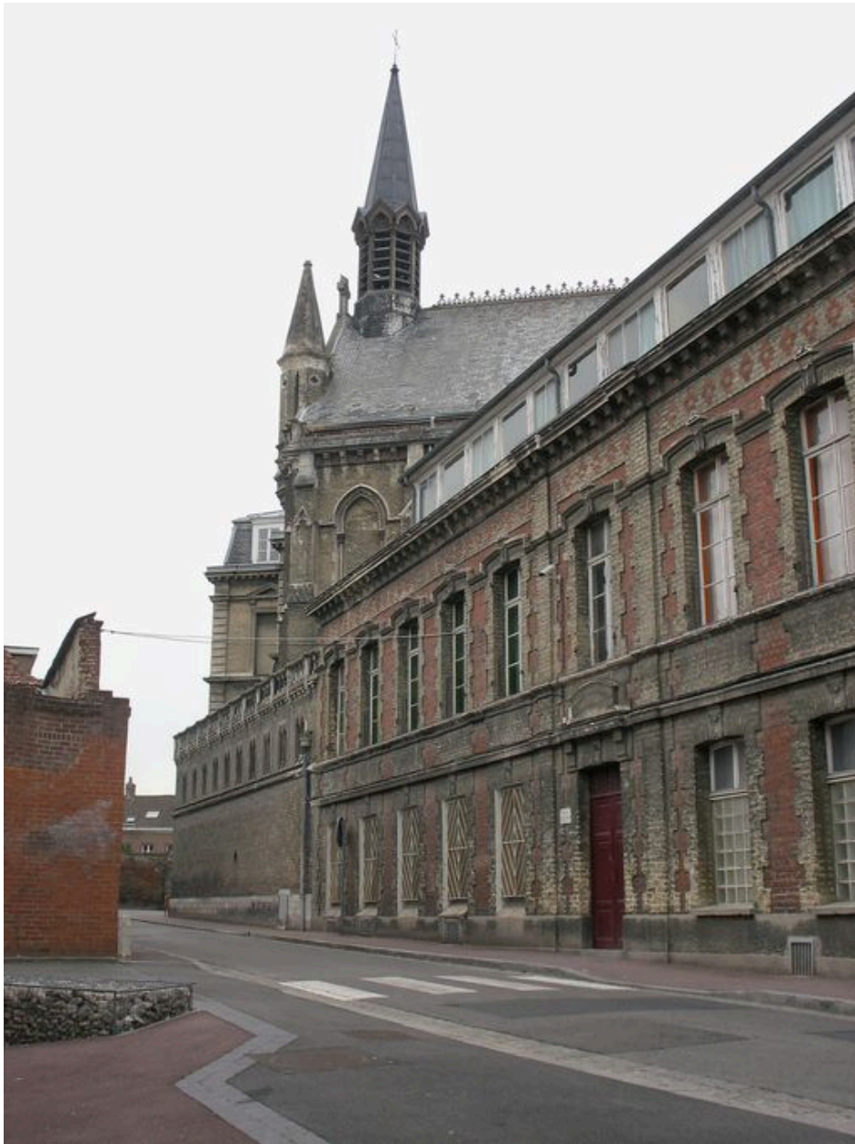
Vue d'ensemble depuis la rue.
