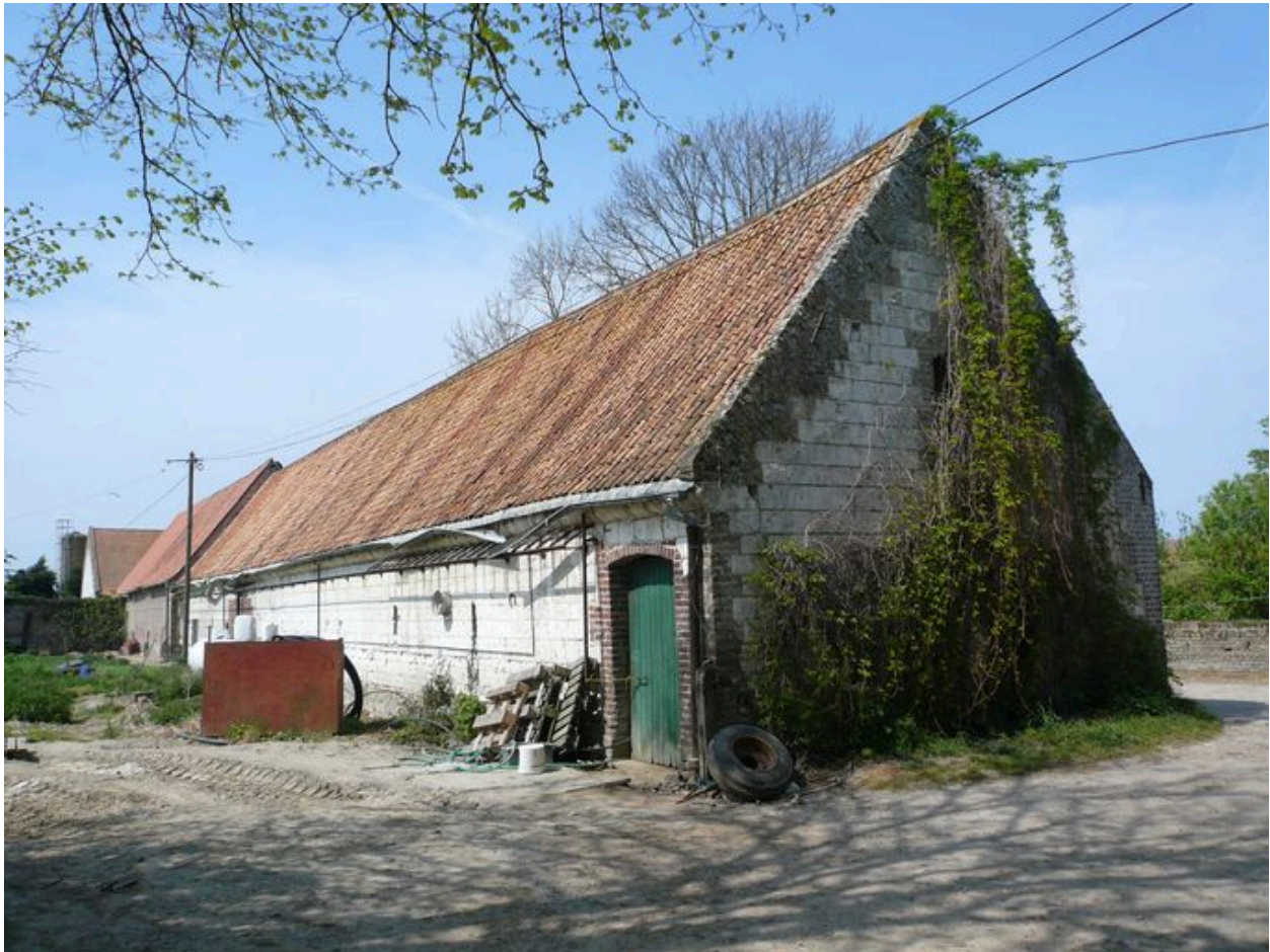
Vue postérieure des étables situées au sud de la cour depuis l'entrée au sud-est.
