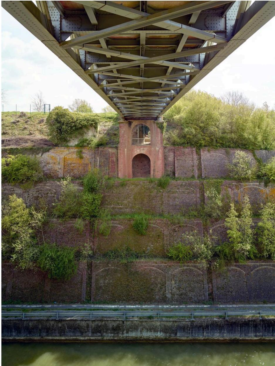
Vue sous le pont routier sud (depuis la rive est). Culée du pont, murs de soutènements en gradins.
