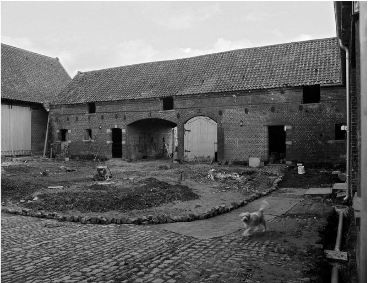
Vue générale des étables-écuries.
