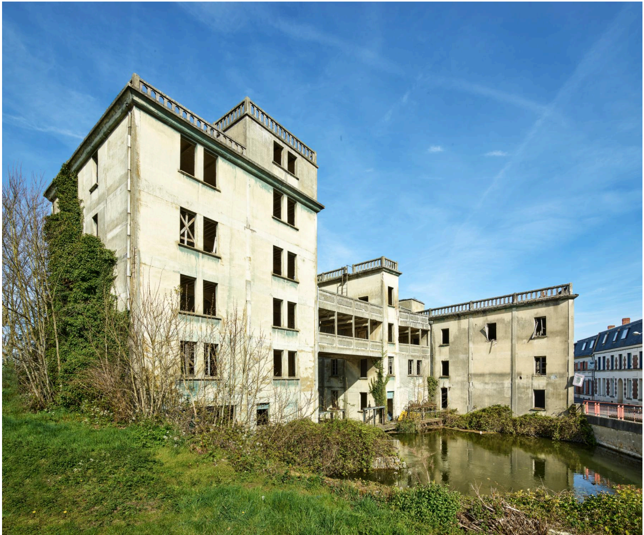
Vue générale sud-est de la minoterie.
