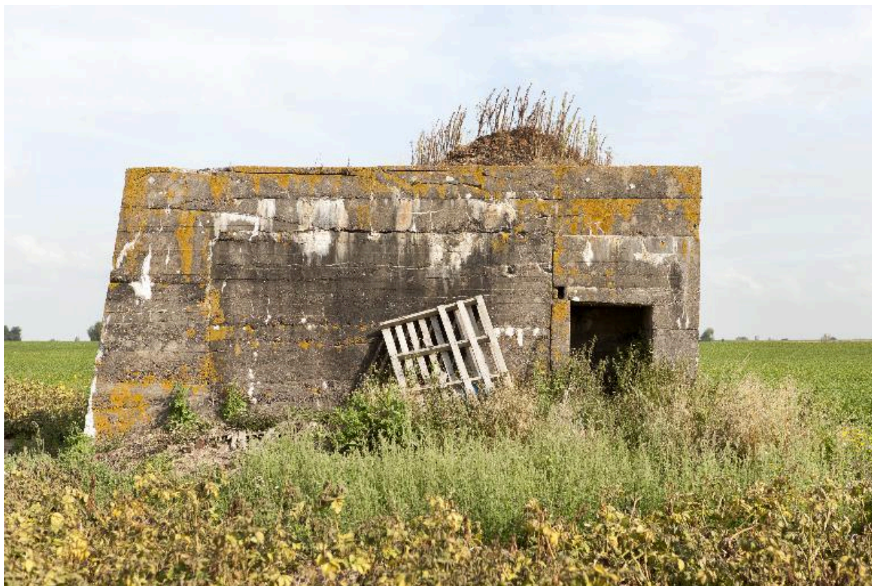
Elévation sud. Entrée
