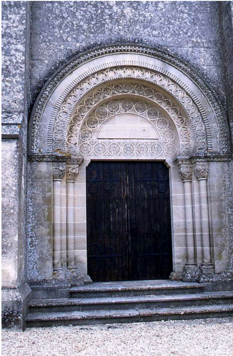
Vue détaillée du portail.
