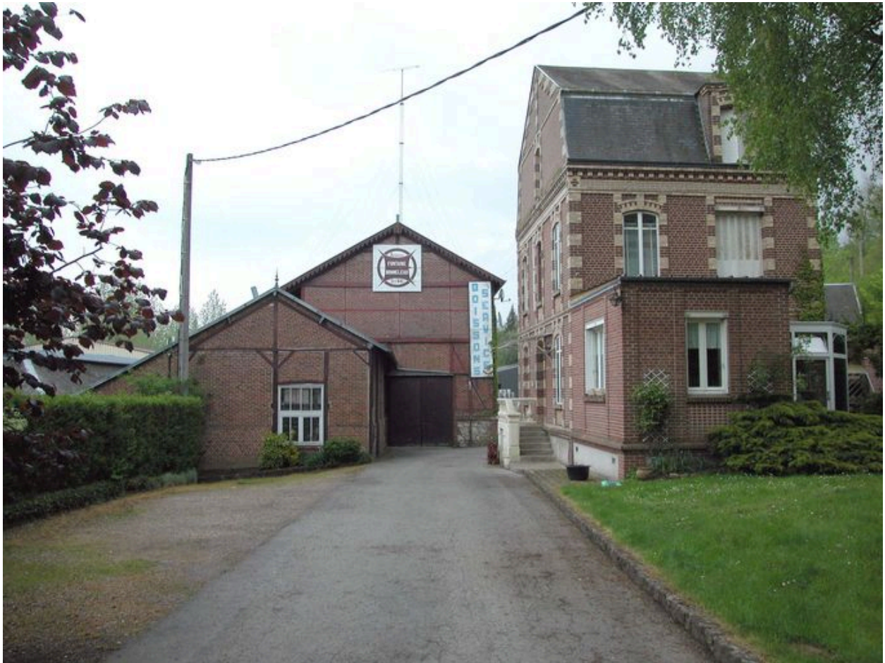
Vue d'ensemble depuis l'entrée de l'usine.
