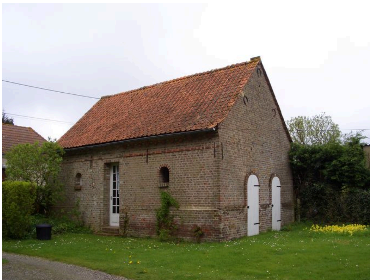
Vue des écuries sur rue.
