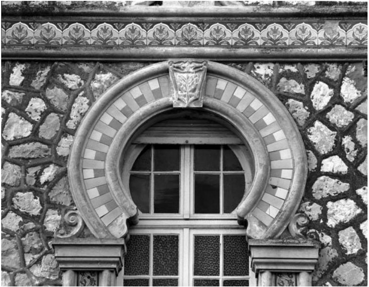
Détail de fenêtre au rez-de-chaussée de la façade latérale droite.
