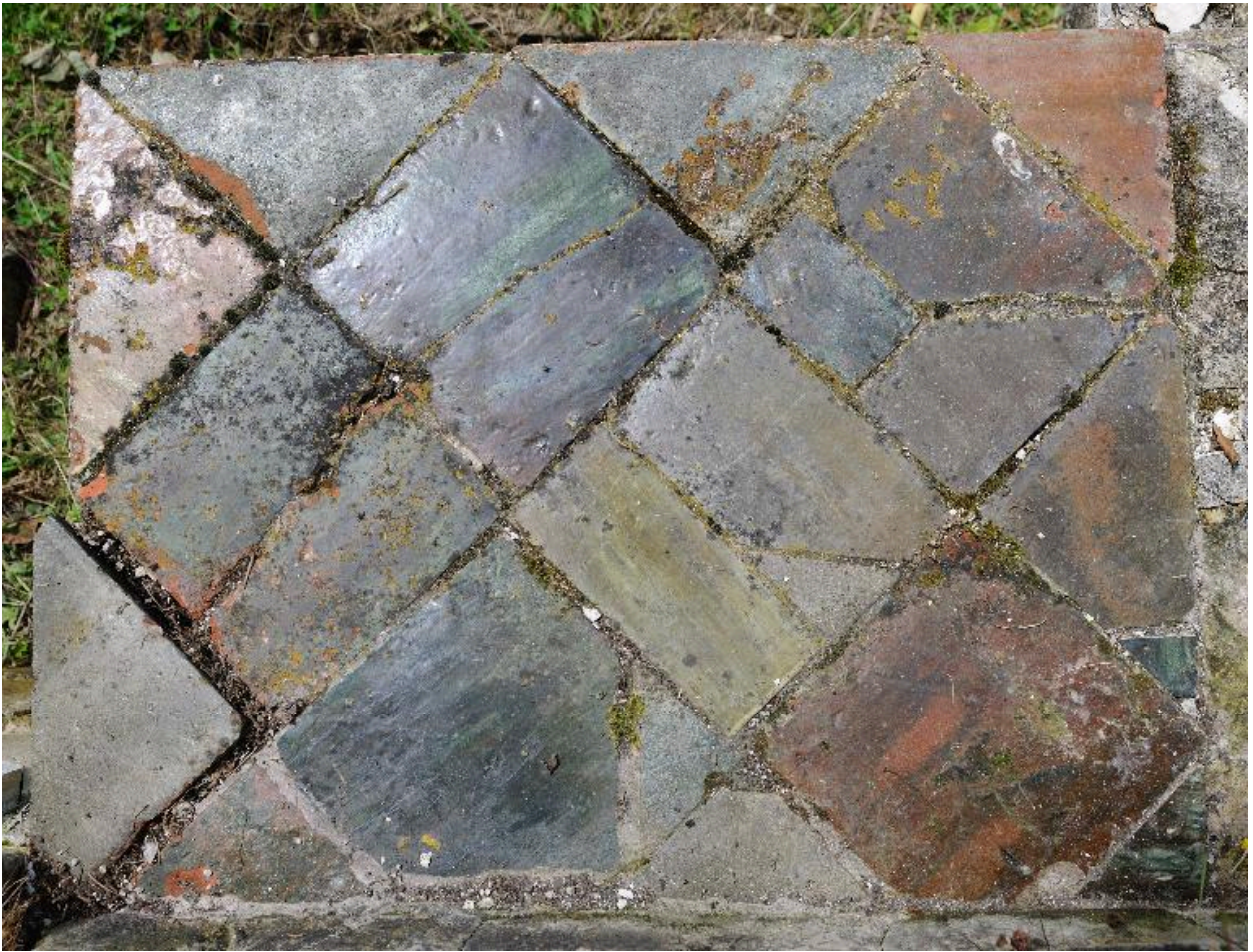
Éléments de carrelage de grès dans la nef de l'ancienne église priorale.
