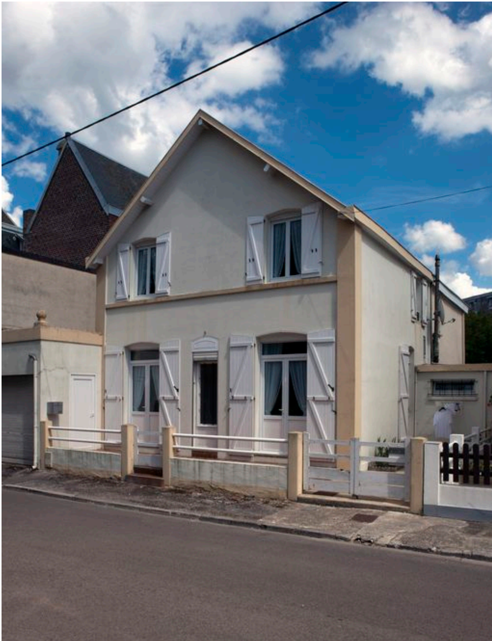
Façade du 5 rue Chambon.
