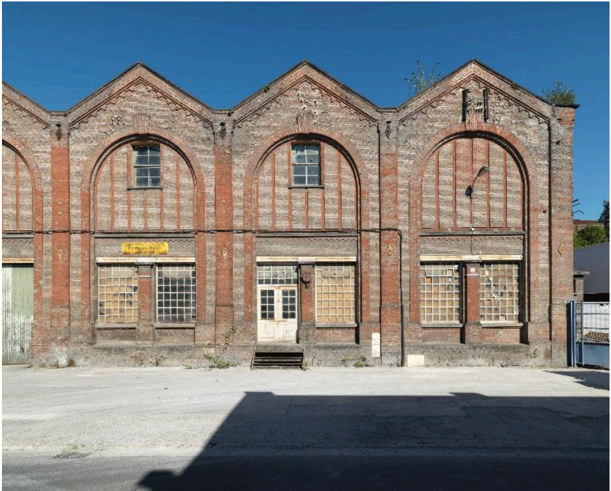
Détail des pignons est de la bâcherie.
