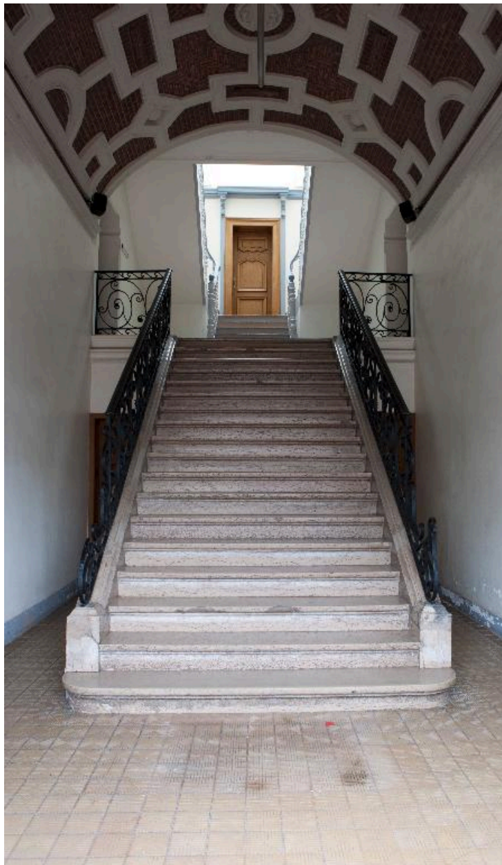
Vue générale de l'escalier depuis l'entrée (rez-de-chaussée).
