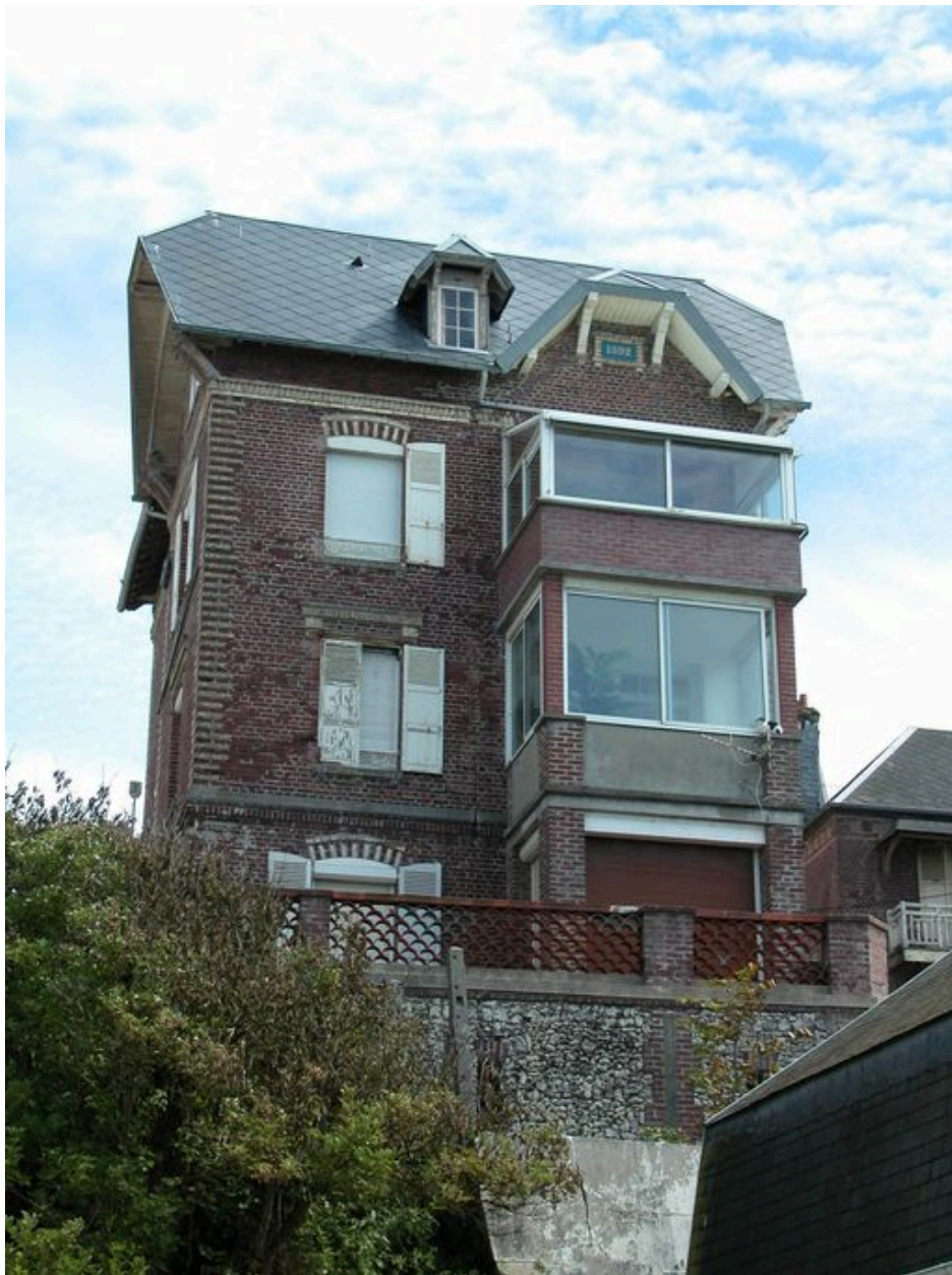
Vue d'ensemble depuis la rue de Saint-Valery, côté mer.
