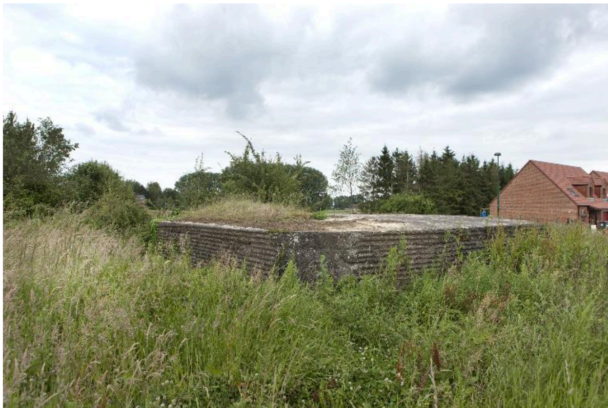
Casemate à personnel (Bat. B)
