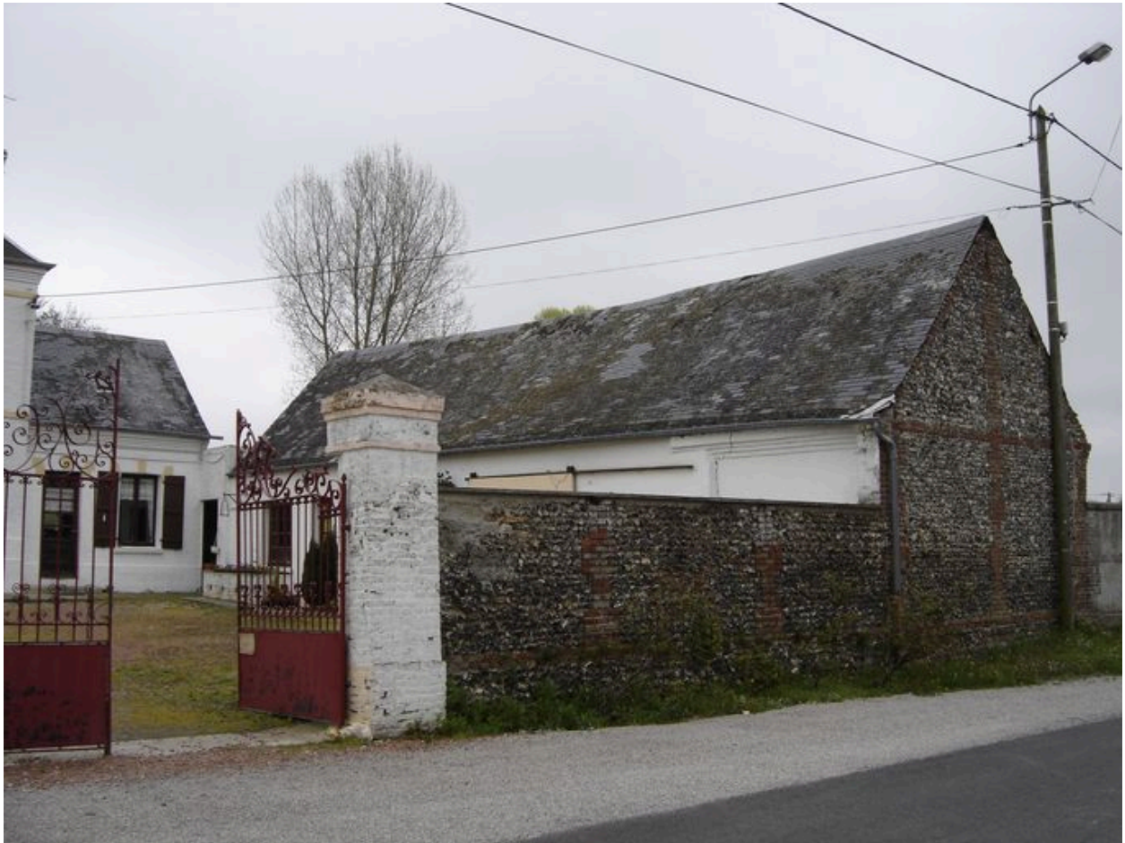
Vue des étables au sud de la propriété.
