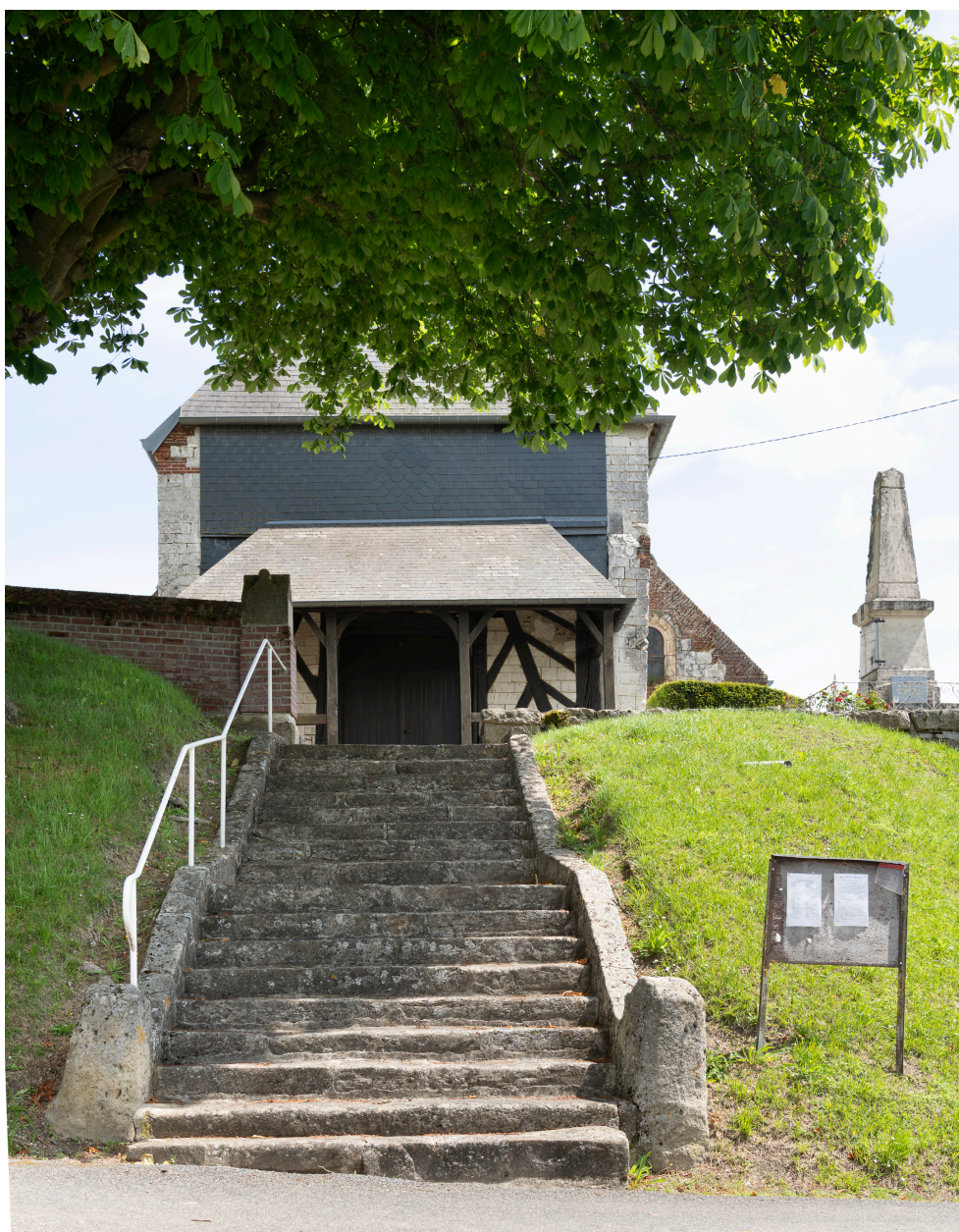
Accès à l'entrée occidentale de l'église.
