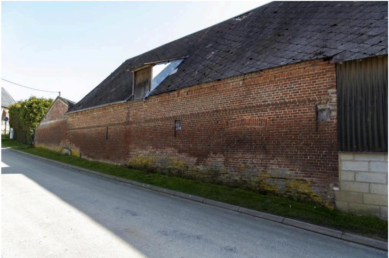
Bâtiments agricoles alignés sur la rue de la ferme au n°2 rue Saint-Pierre, vue depuis le nord.
