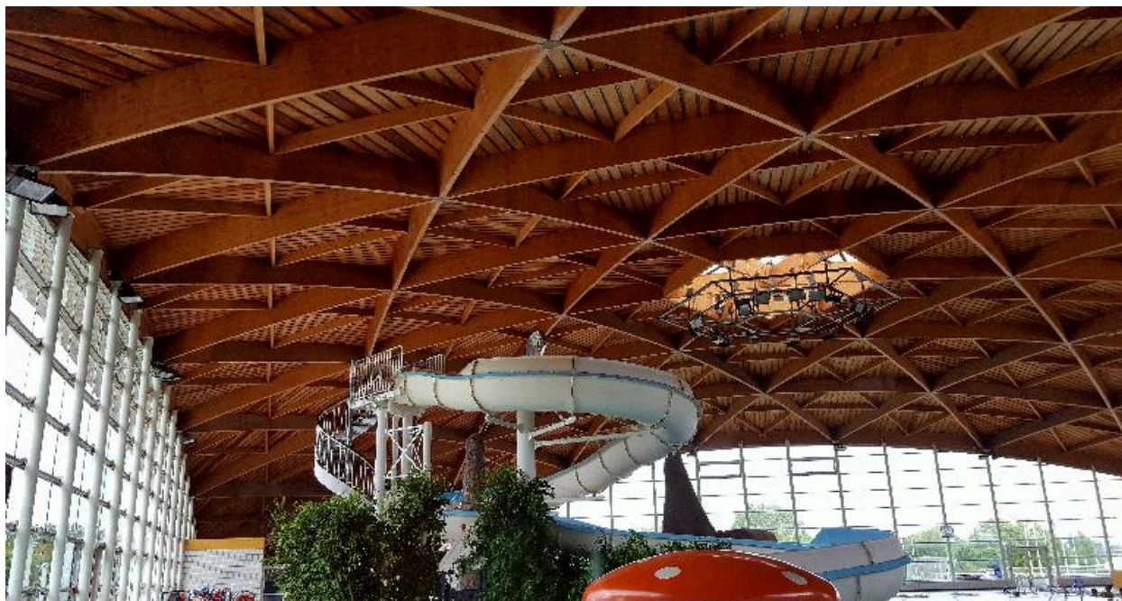
Intérieur du centre nautique de Nogent-sur-Oise.
