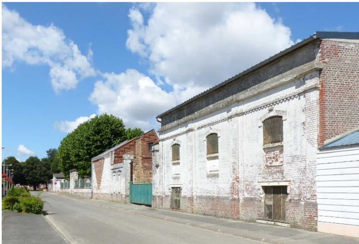
Vue générale, depuis le sud-est.
