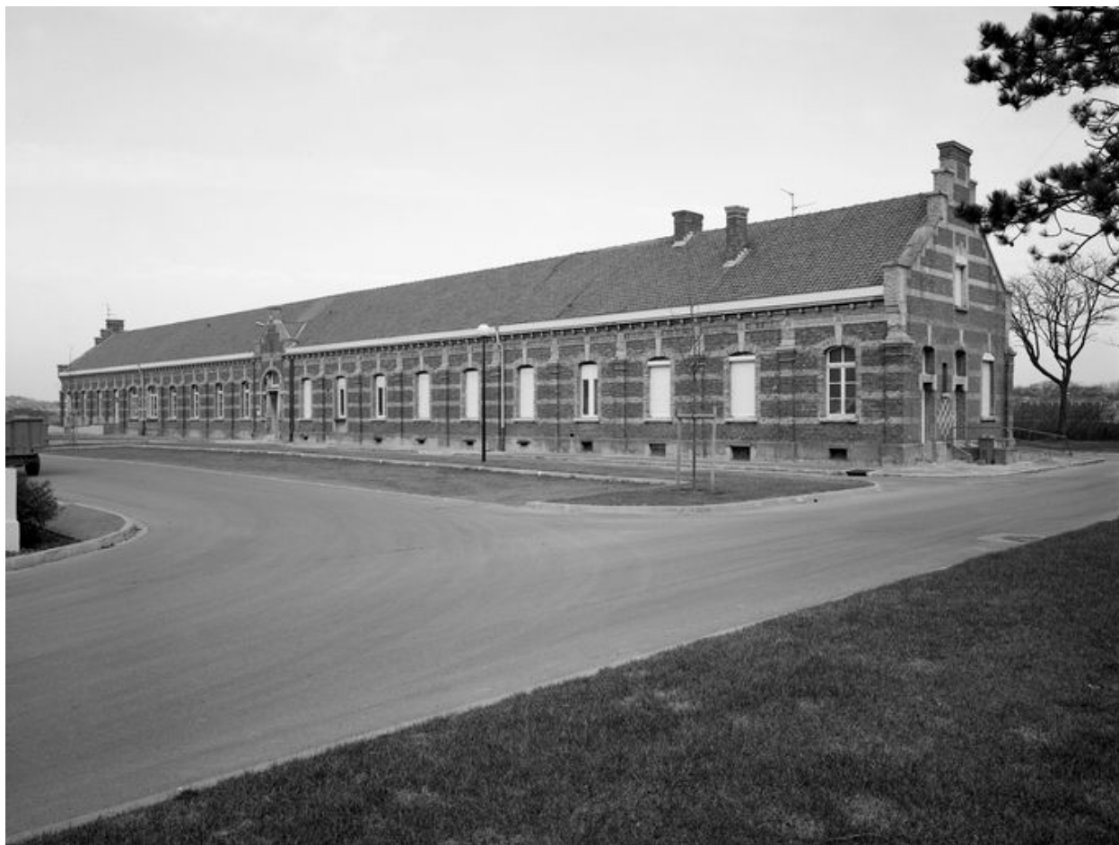
Pavillons des enfants valides, pavillon du groupe est abritant les bains-douches et les gymnases, élévation ouest, vue générale prise de trois quarts droit.
