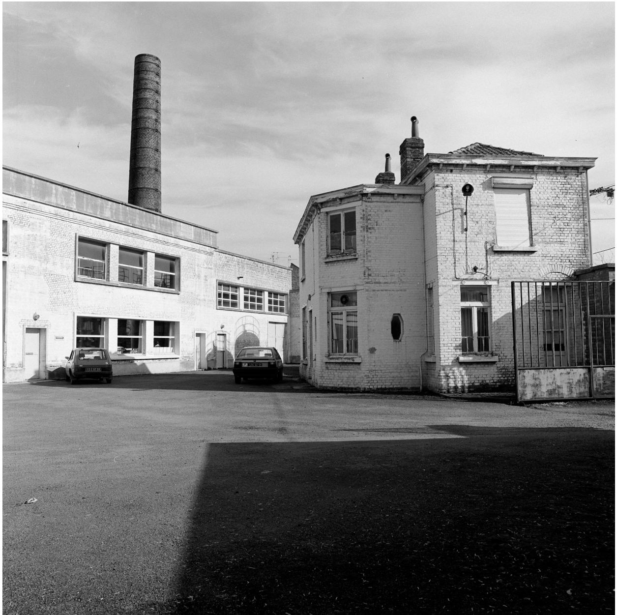
Bureaux. Vue prise depuis la cour.
