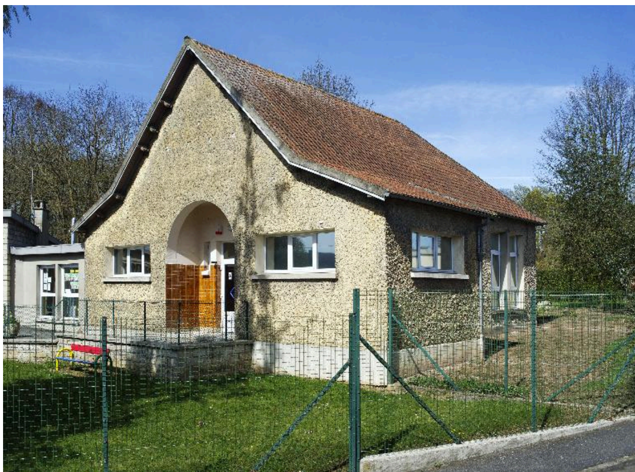
Vue de l'école maternelle construite avant 1931.
