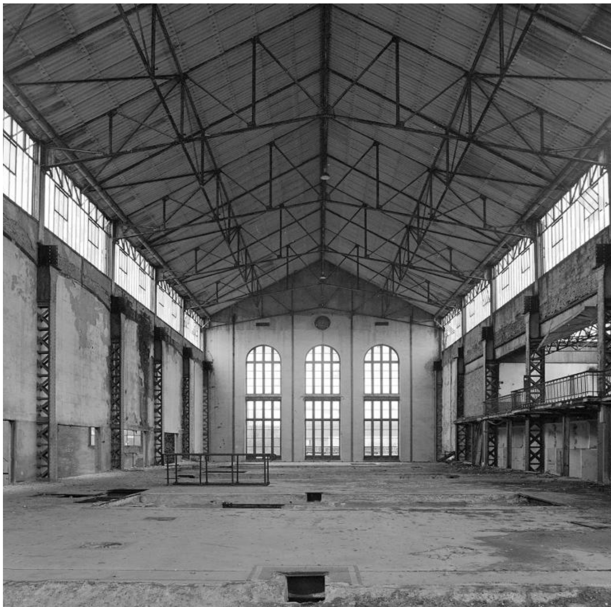
La centrale électrique en 1990 (usine B).
