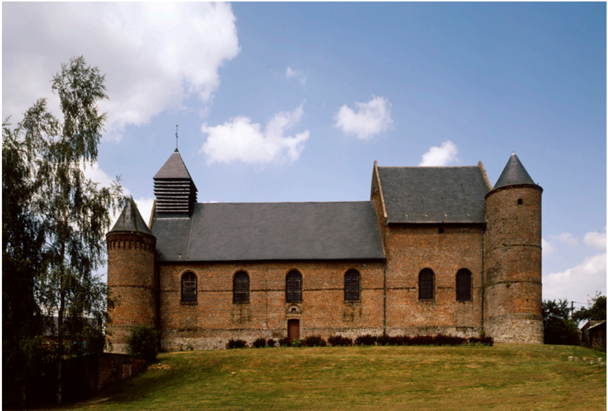
Vue de l'élévation sud.
