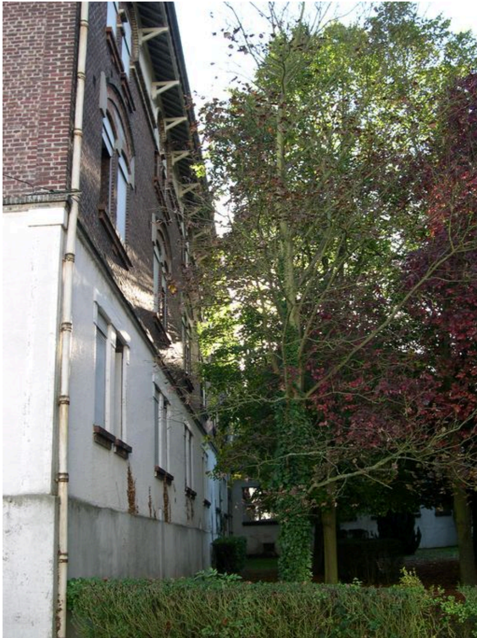
Façade sud, vue depuis le sud-est.
