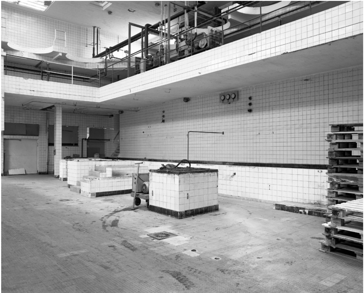
Vue intérieure de l'atelier de fabrication : emplacement des barattes.
