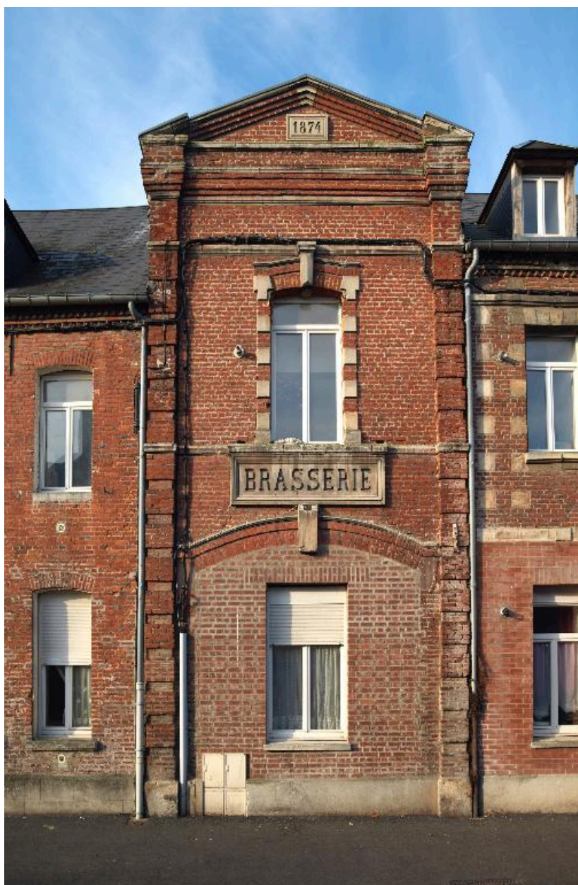
La travée centrale de l'ancienne brasserie.
