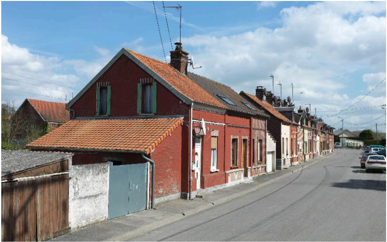
La cité des Avesnes, vue partielle.
