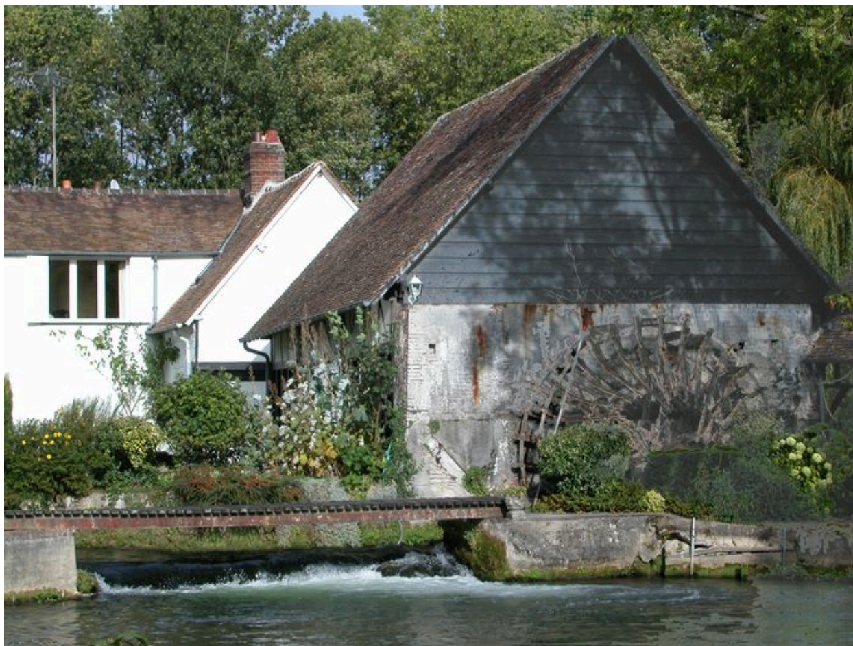
Vue du pignon du moulin hydraulique.
