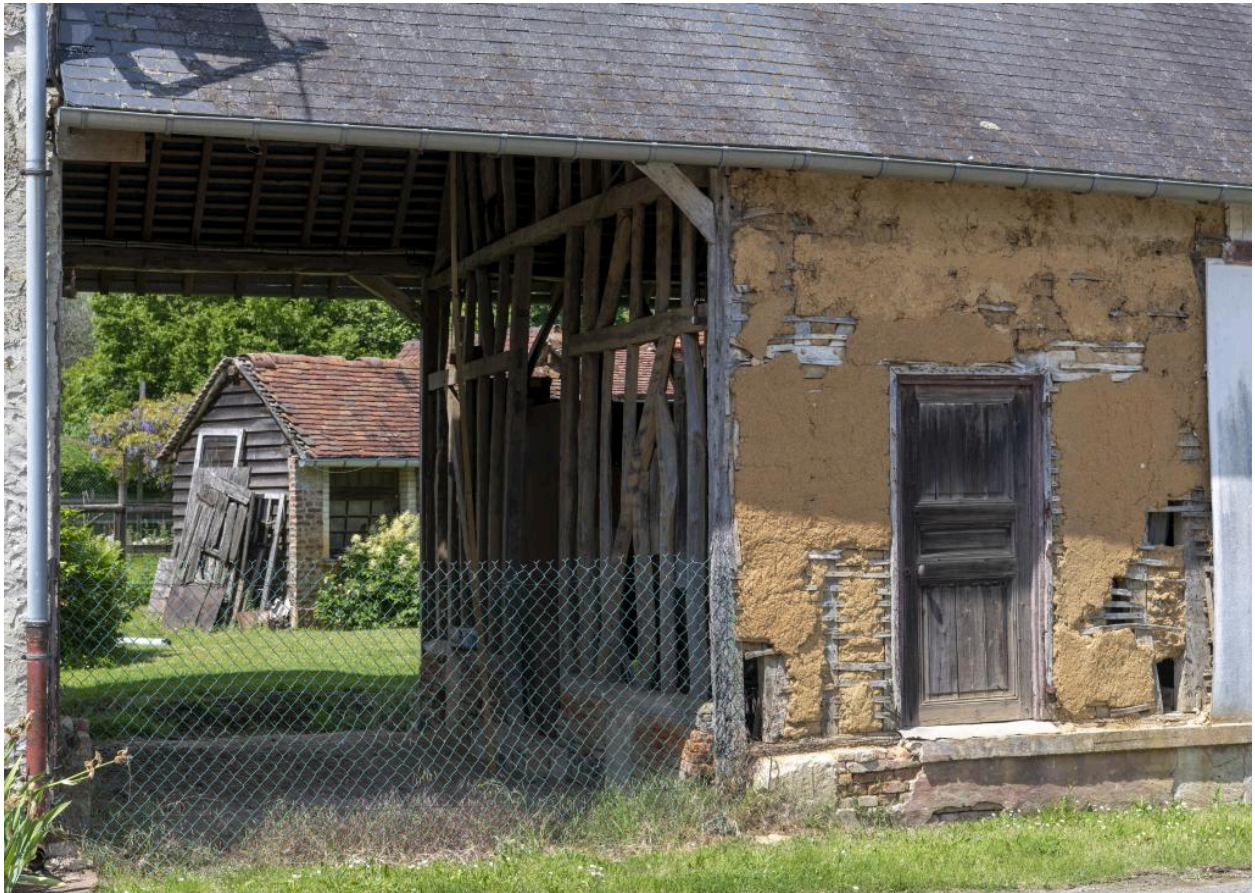
Détail d'une entrée charretière en pans de bois et torchis, n°17 Grande Rue, vue depuis le sud-est.
