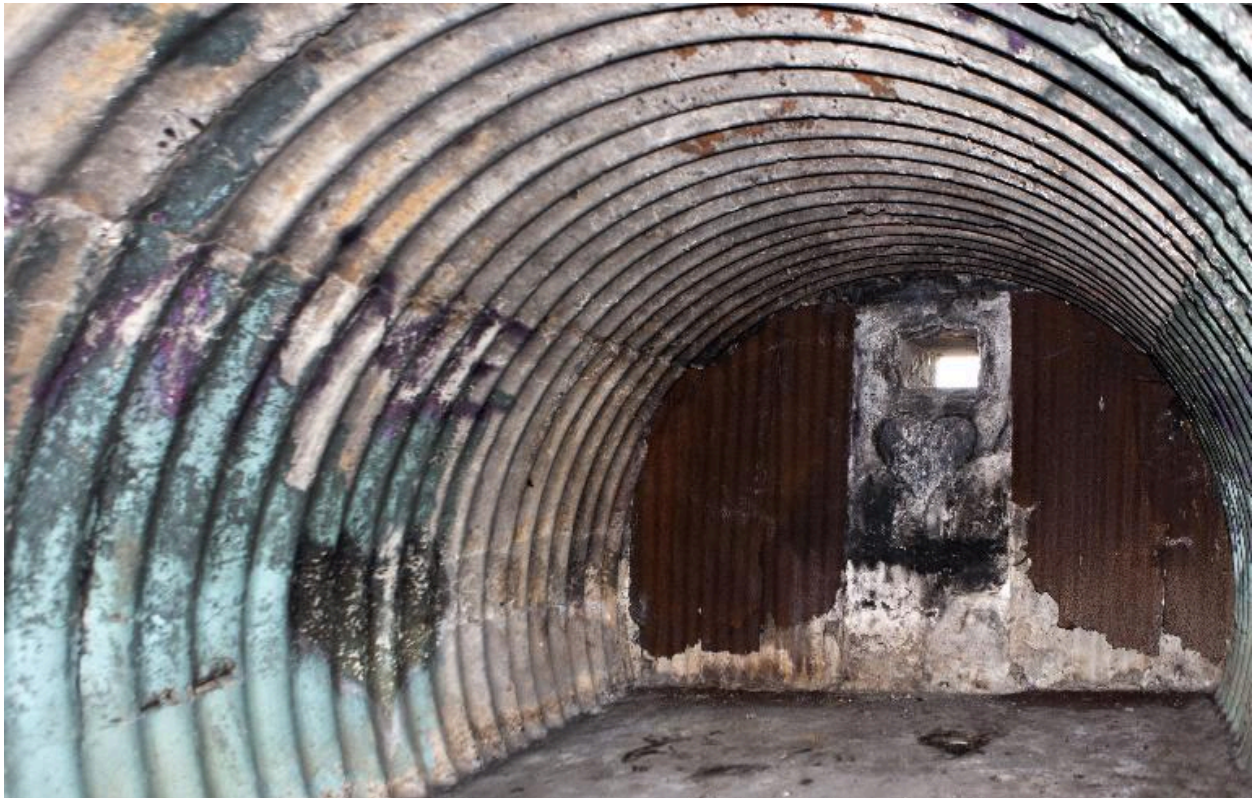
Vue intérieure de l'abri, vers le nord-ouest
