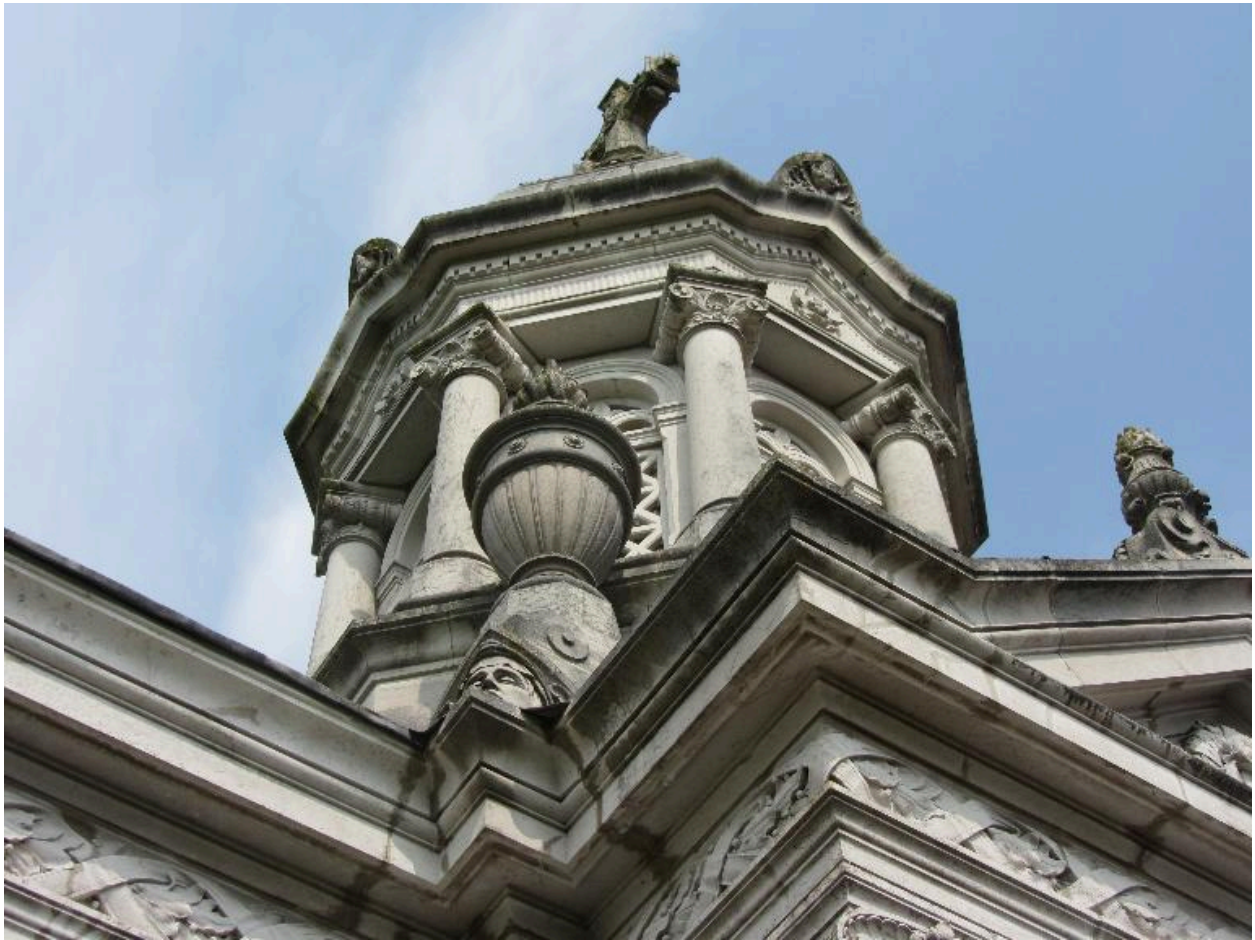
Détail des pots à feux.
