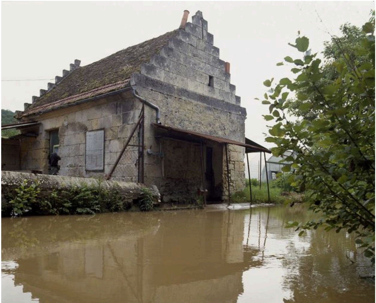
Le bassin de retenue.
